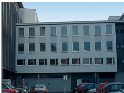
Рис. 3. Фасад здания, для которого проводены термографические исследования
