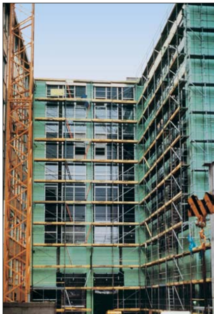
Рис. 5. Теплоизоляция мостиков холода с помощью Styrodur® 2800CS
